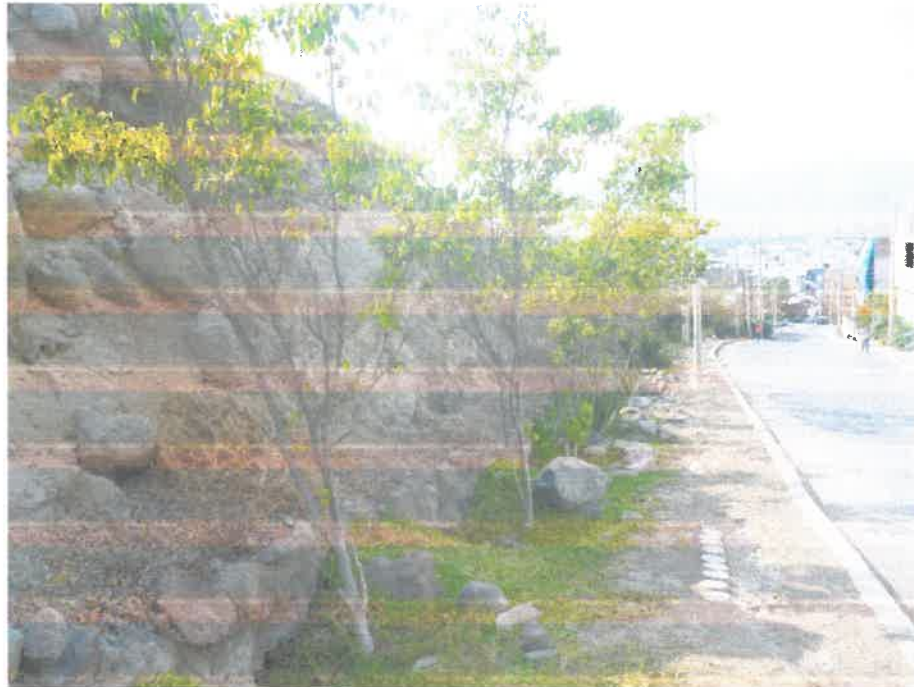
FOTOGRAFÍA N° 49: Vista de un corte existente en la Calle La Punta, cerca de la calicata C-8. Nótase el macizo rocoso, Conglomerado de origen sedimentario.
