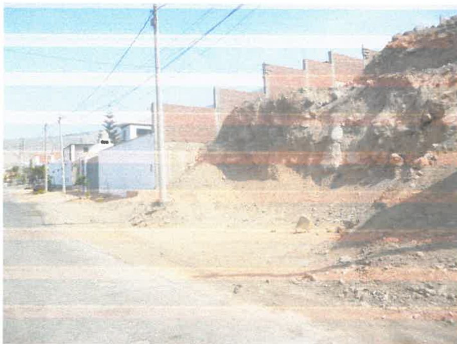
FOTOGRAFÍA N° 46: Vista de un corte existente al interior de un predio urbano. Nótase el macizo rocoso, Conglomerado de origen sedimentario.
