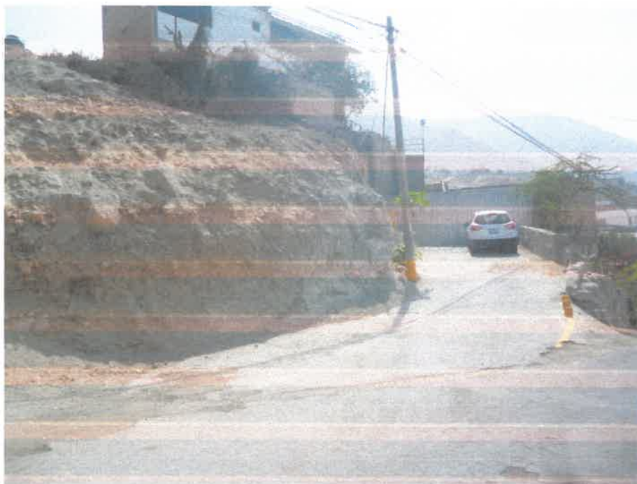
FOTOGRAFÍA N° 45: Vista de un corte existente al interior de un predio urbano, cerca de la calicata C-3. Nótase que el Conglomerado de origen sedimentario ha sido intruído por Gabrodiorita de origen volcánico intrusivo.
