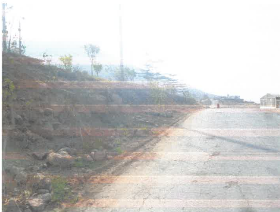
FOTOGRAFÍA N° 48: Vista de un corte existente en la Av. Los Andes, cerca de la calicata C-7. Nótase el macizo rocoso, Conglomerado de origen sedimentario.
