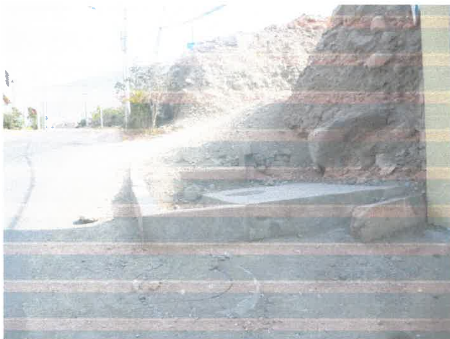
FOTOGRAFÍA N° 50: Vista de un corte existente en la Calle La Punta, cerca de la calicata C-9. Nótase el macizo rocoso, Conglomerado de origen sedimentario.
