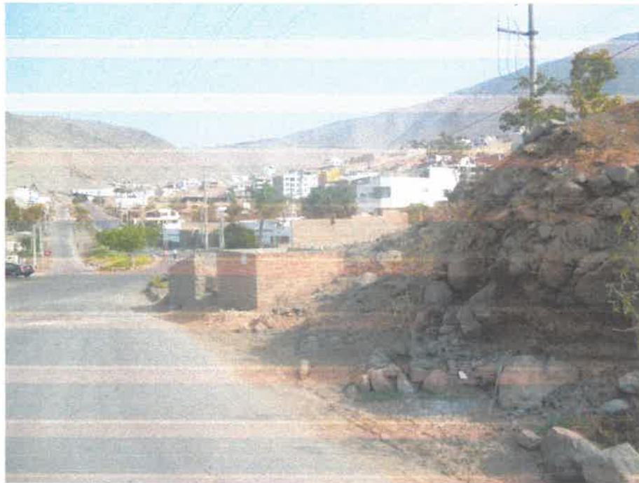
FOTOGRAFÍA N° 47: Vista de un corte existente en la Av. Los Andes, cerca de la calicata C-6. Nótase el macizo rocoso, Conglomerado de origen sedimentario.
